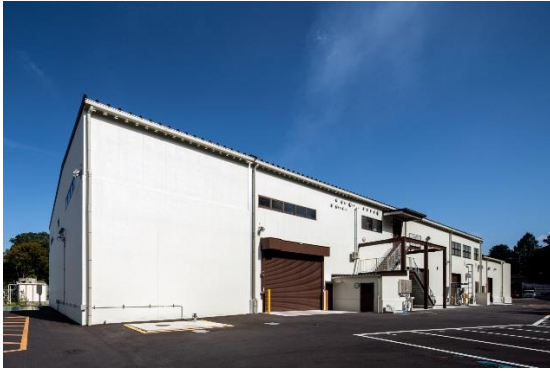
バイオマス発電プラント（外観）
